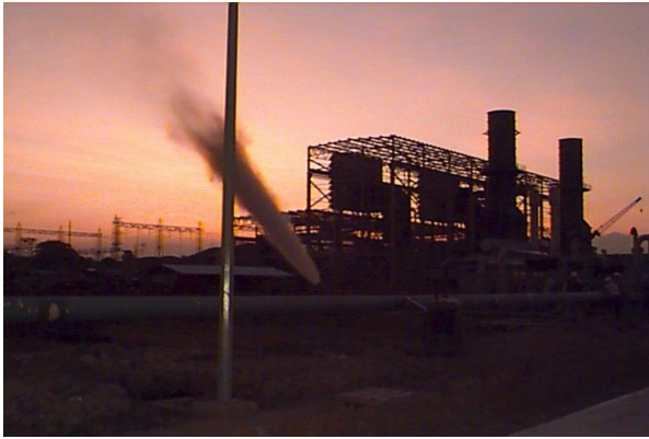
Foto: soplado del gasoducto.
