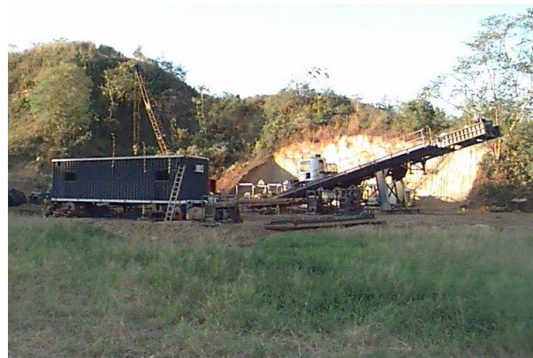
Foto: Máquina para la ejecución de la perforación dirigida de 750 m por debajo del río Magdalena en la margen opuesta a la de la obra
