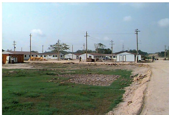
Foto: Nuestro campamento y casetas temporales, vivienda y oficinas. Cuarto mes.
