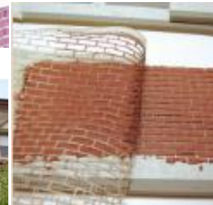
Aplicando la plantilla para el estarcido.
