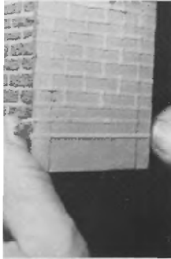
Colocando las tiras de cinta en las juntas horizontales.
