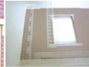
Aplicando la plantilla para el estarcido.
